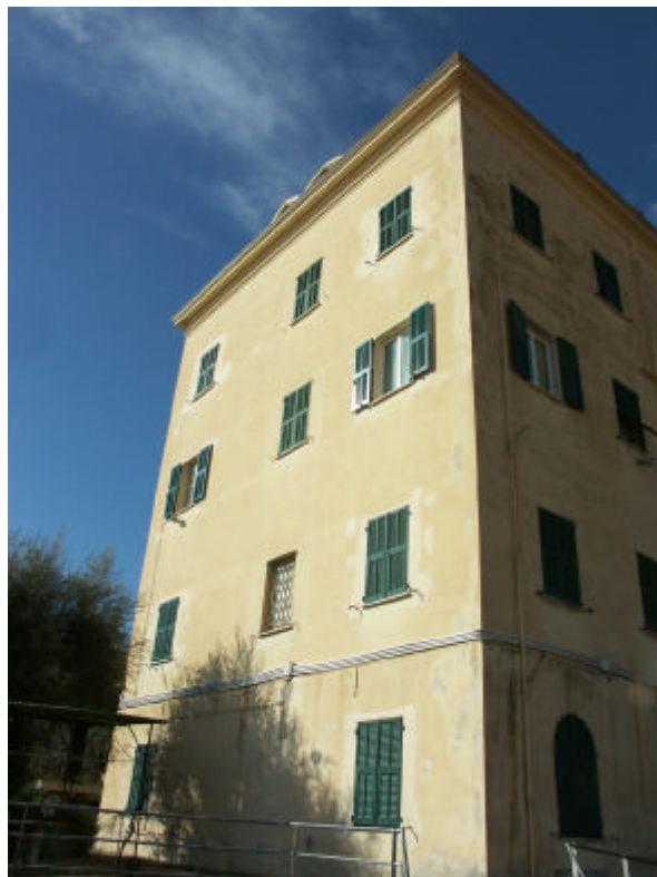
-7- Vista della facciata lato sud-est
