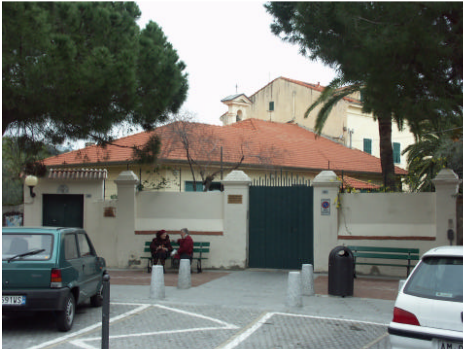
-2- Vista del complesso da p.zza San Bernardo
