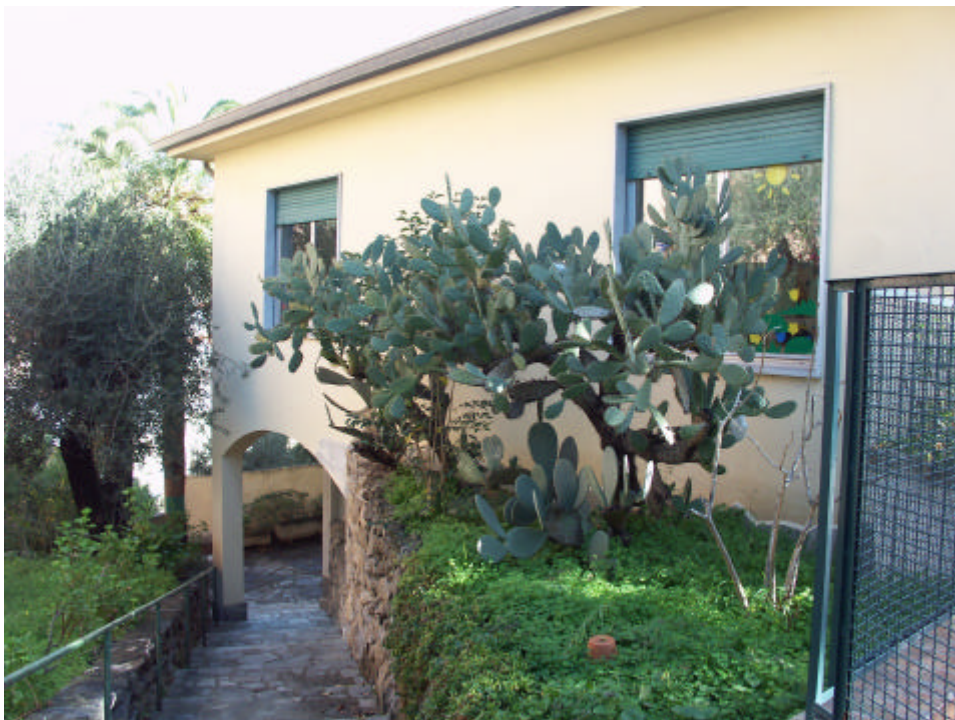
-3- Vista della scuola materna lato nord
