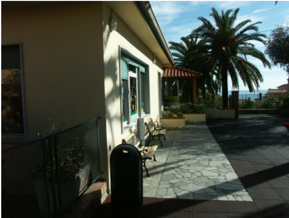
-4- Vista della scuola materna lato nord-ovest
