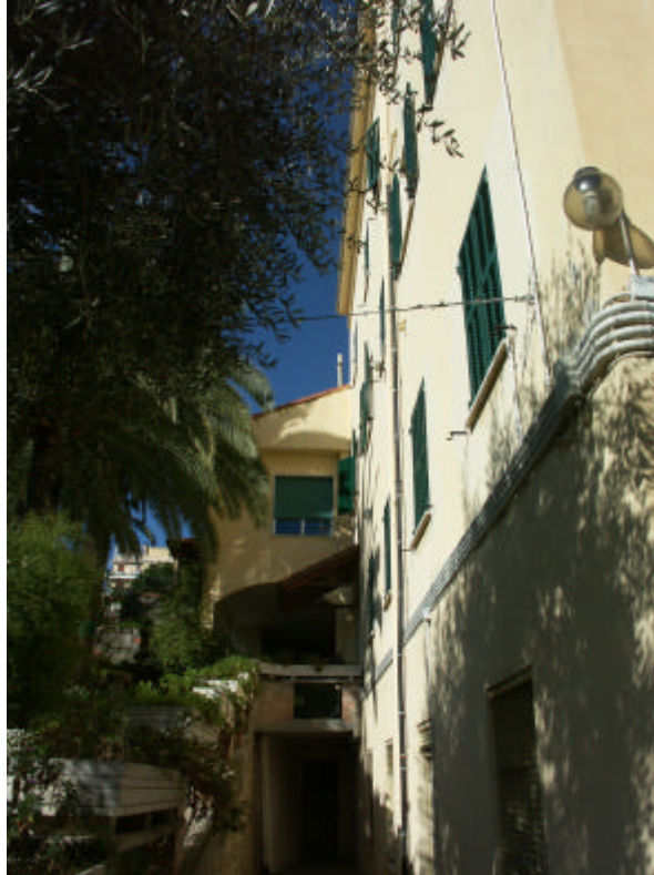
-6- Vista della facciata lato ovest
